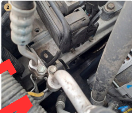
2 Utascella és gyűrődő zónák A nyűlvánnyakon javításra utaló nyomok nem találhatók.
